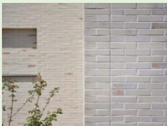
Die Fassaden der Bestandsgebäude sind mit schlanke, hellen Klinker-Riemchen im Farbton Passo FK von GIMA gestaltet und betonen den industriellen Charakter des historischen Ensembles.
