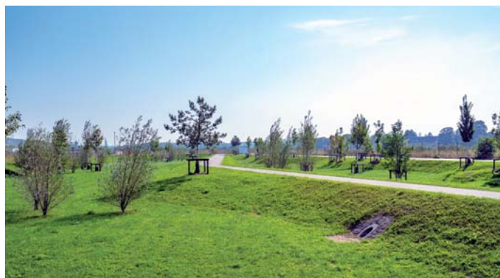
Begrünte Retentionsräume halten das Niederschlagswasser von Starkregenereignissen zurück und geben es verzögert an die Kanalisation oder den Untergrund ab. Foto: Tim Rosentreter/Knappmann GmbH & Co. Landschaftsbau KG, Projekt: 6-Seen-Wedau, Duisburg
