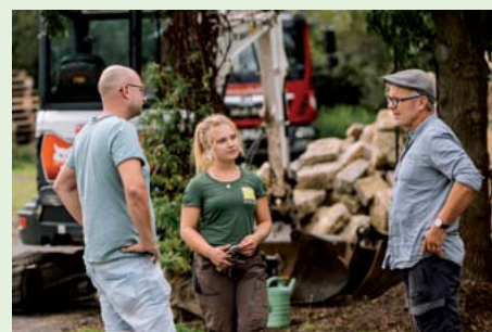
Christian Schelleis sieht heute vieles entspannter als früher: „Ich rege mich nicht mehr auf. Die Ener-gie stecke ich lieber in die Lösung des Problems.“
