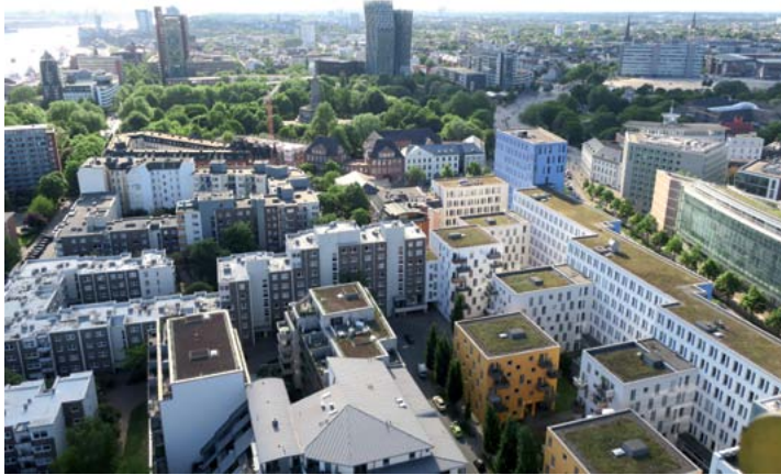
Auch Dachbegrünungen mit dünnen Substratschichten bieten Retentions- und Verdunstungsflächen bei Starkregen. Foto: Daniel Westerholt
