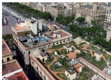
Der Dachgarten des Porxos d'en Xifré: So schön könnte es auf jedem Flachdach in Barcelona aussehen. Foto: MataAlta Studio
