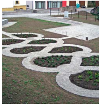
Nach dem Einbau
