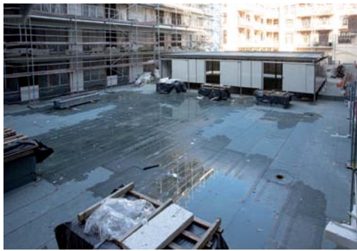
Das Projekt „Gerichtsweg“ in Leipzig (2021). Vorher: Groß-Baustelle inmitten von Wohnhäusern.
